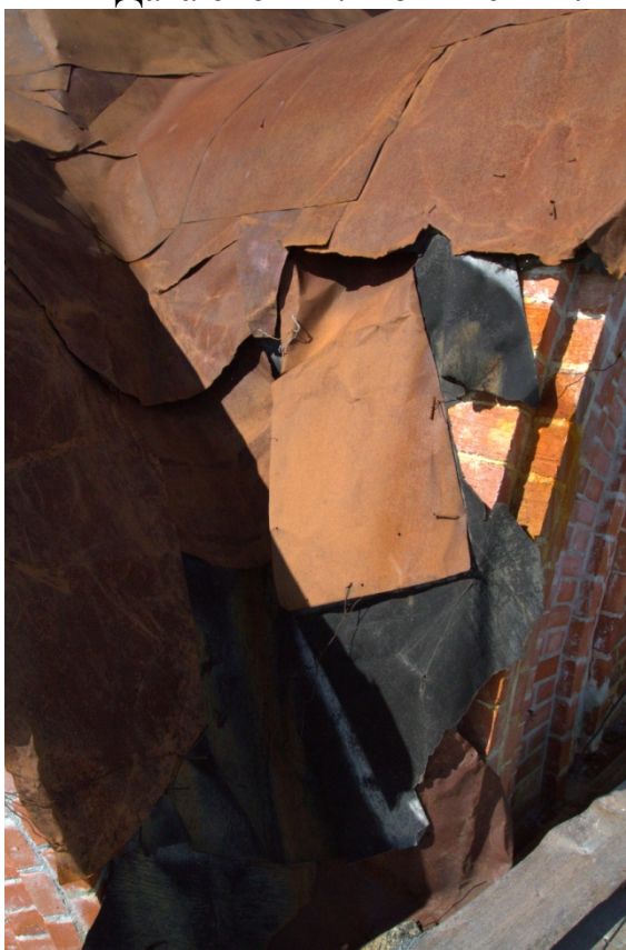
10. Повреждённый участок покрытия в ендове храма Святой Троицы. Дата съёмки: июнь 2014 г.
