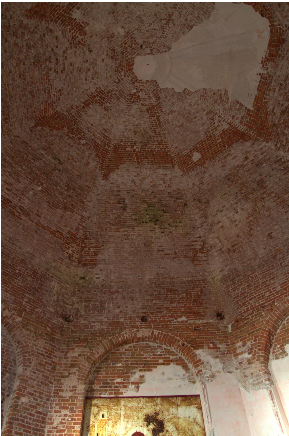
11. Участок замачивания свода храма Святой Троицы, выкрашивание кладки и раствора, плесень, трещины по ребрам свода. Вид изнутри на восточную стену. Дата съемки: июнь 2014 г.
