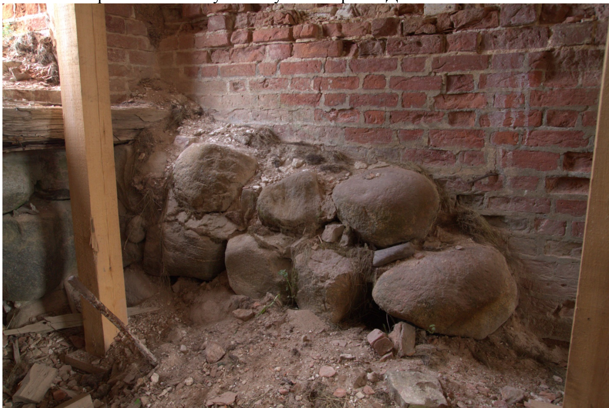
19. Незакреплённые валуны кладки фундамента храма Святой Троицы. Вид из паперти на восточную стену восьмерика. Дата съемки: июнь 2014 г.
