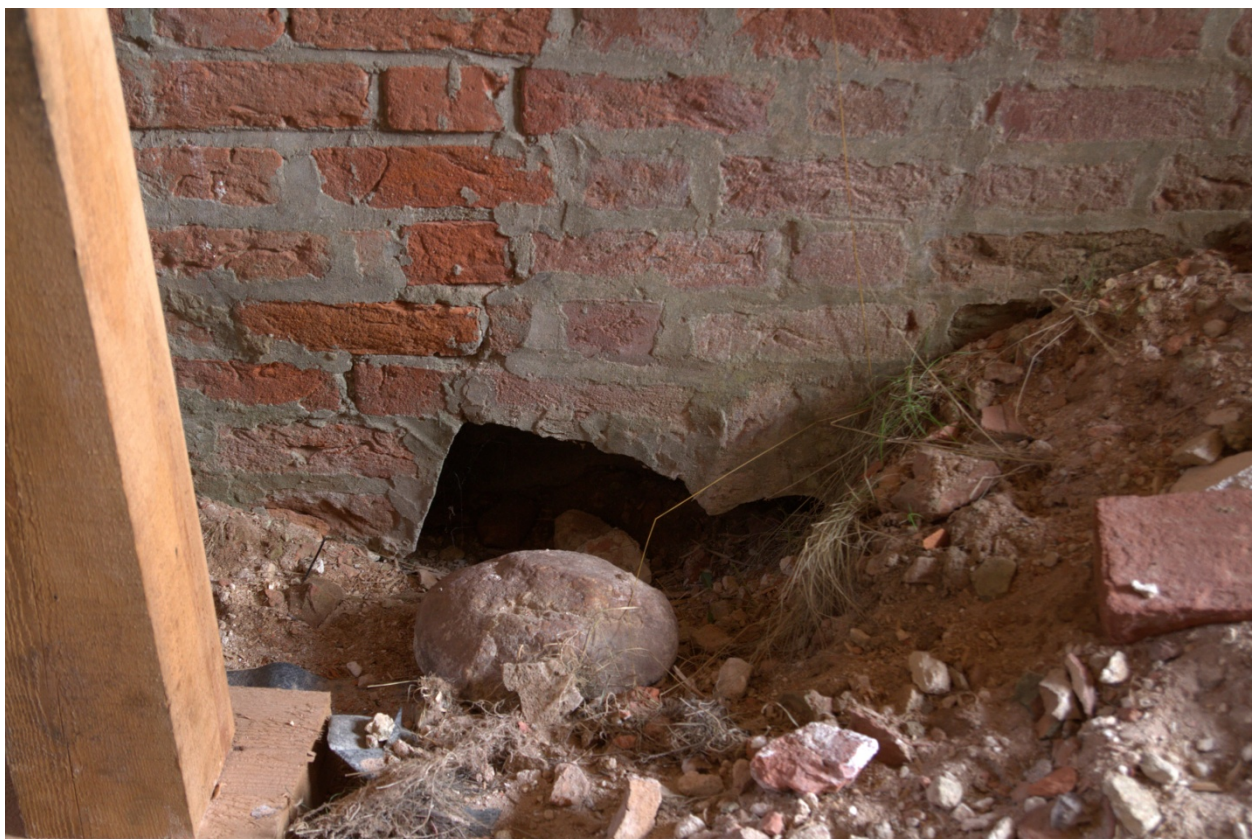
18. Вывал камней из подошвы фундамента стены храма Святой Троицы. Вид из паперти на восточную стену восьмерика. Дата съемки: июнь 2014 г.
