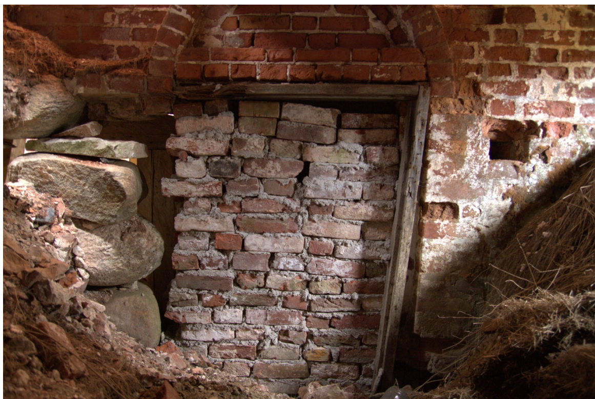
15. Аварийный участок фундамента храма Святой Троицы (разрушенная валунная кладка ф-та, заложенный дверной проём в подвал). Вид с севера из под временной кровли входа в подвал. Дата съемки: июнь 2014 г.
