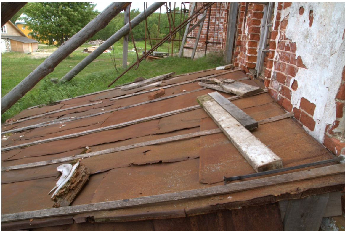
14. Временное покрытие входа в подполье храма Святой Троицы (отсутствие примыкания кровли к кладке, износ кровли). Дата съемки: июнь 2014 г.
