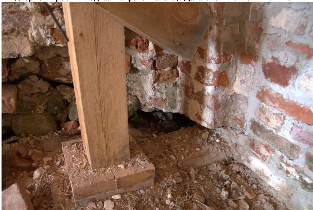
17. Отсутствие кладки в основании ф-та на участке между заложённым дверным проёмом в подвал (справа) и стеной храма Михаила Малеина (слева). Интерьер храма. Дата съёмки: июнь 2014 г.
