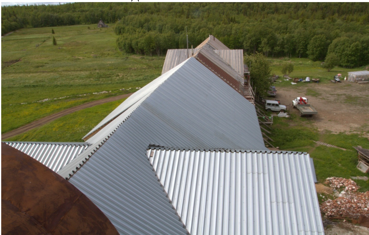
6. Консервационная кровля, кровля келейного корпуса. Вид с кровли вось- мерика храма Святой Троицы. Дата съемки: июнь 2014 г.
