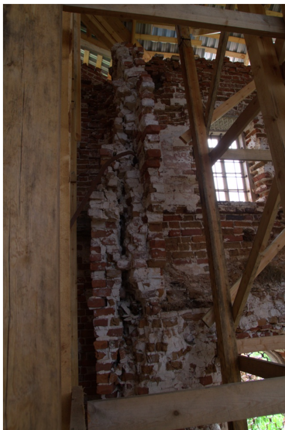
12. Аварийная стена между храмом Святой Троицы и храмом Михаила Малеина. Вид на южный участок стены. Дата съемки: июнь 2014 г.
