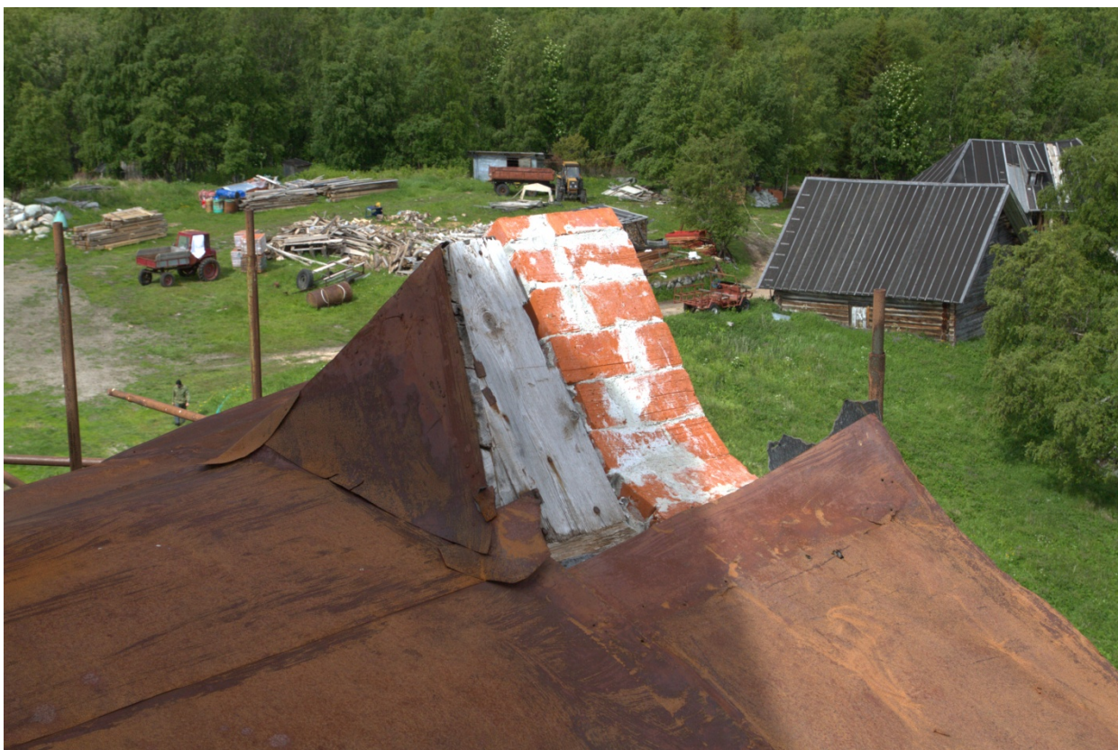
9. Повреждённый участок покрытия кокошника храма Святой Троицы. Дата съёмки: июнь 2014 г.
