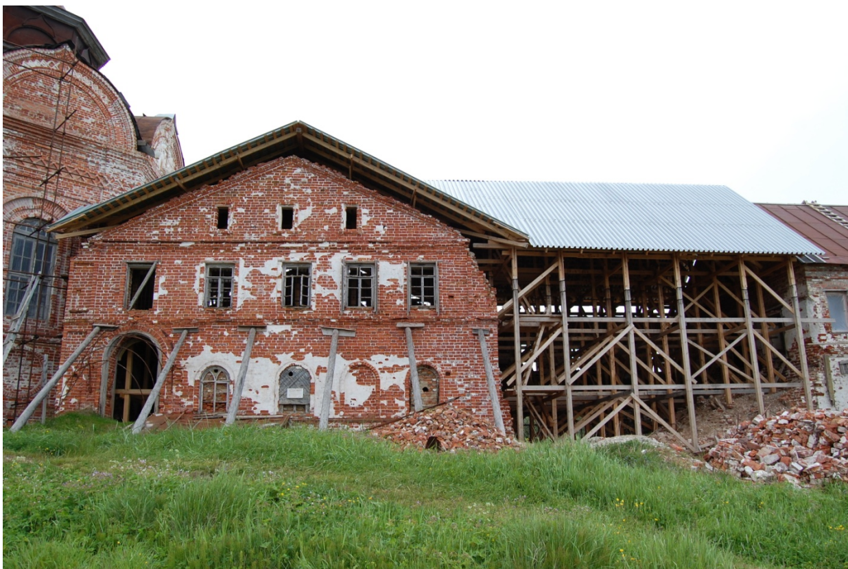
5. Вид Троицкого храма с севера. Консервационная кровля. Дата съемки: июнь 2014 г.
