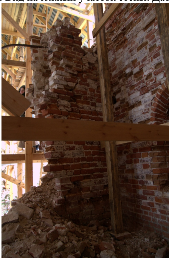
13. Аварийная стена между храмом Святой Троицы и храмом Михаила Малеина. Вид на северный участок стены. Дата съемки: июнь 2014 г.
