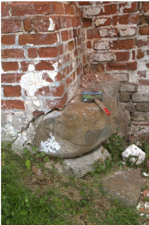
20. Подвижные валуны в кладке фундамента. Северо-западный угол храма Святой Троицы. Дата съемки: июнь 2014 г.
