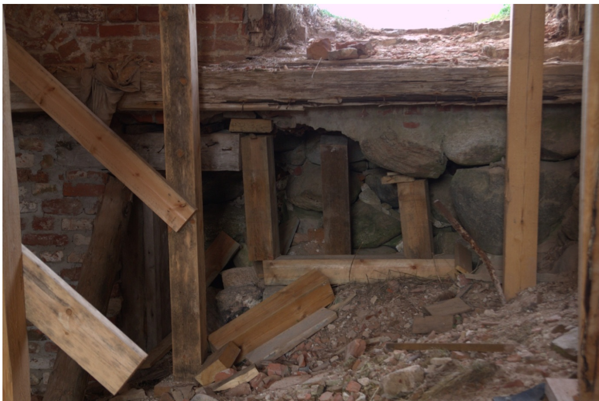
16. Аварийный участок фундамента храма Святой Троицы (разрушенная валунная кладка ф-та, подпорные стойки выключены из работы). Вид из храма (заложённый дверной проём в подвал на фото - слева). Дата съёмки: июнь 2014 г.
