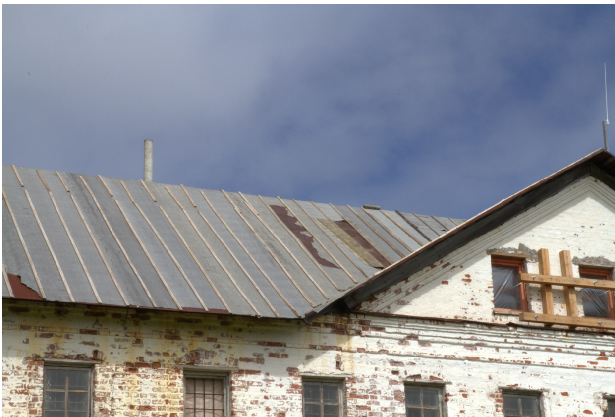
7. Повреждение ковра временной рулонной кровли келейного корпуса. Северный фасад. Дата съемки: июнь 2014 г.
