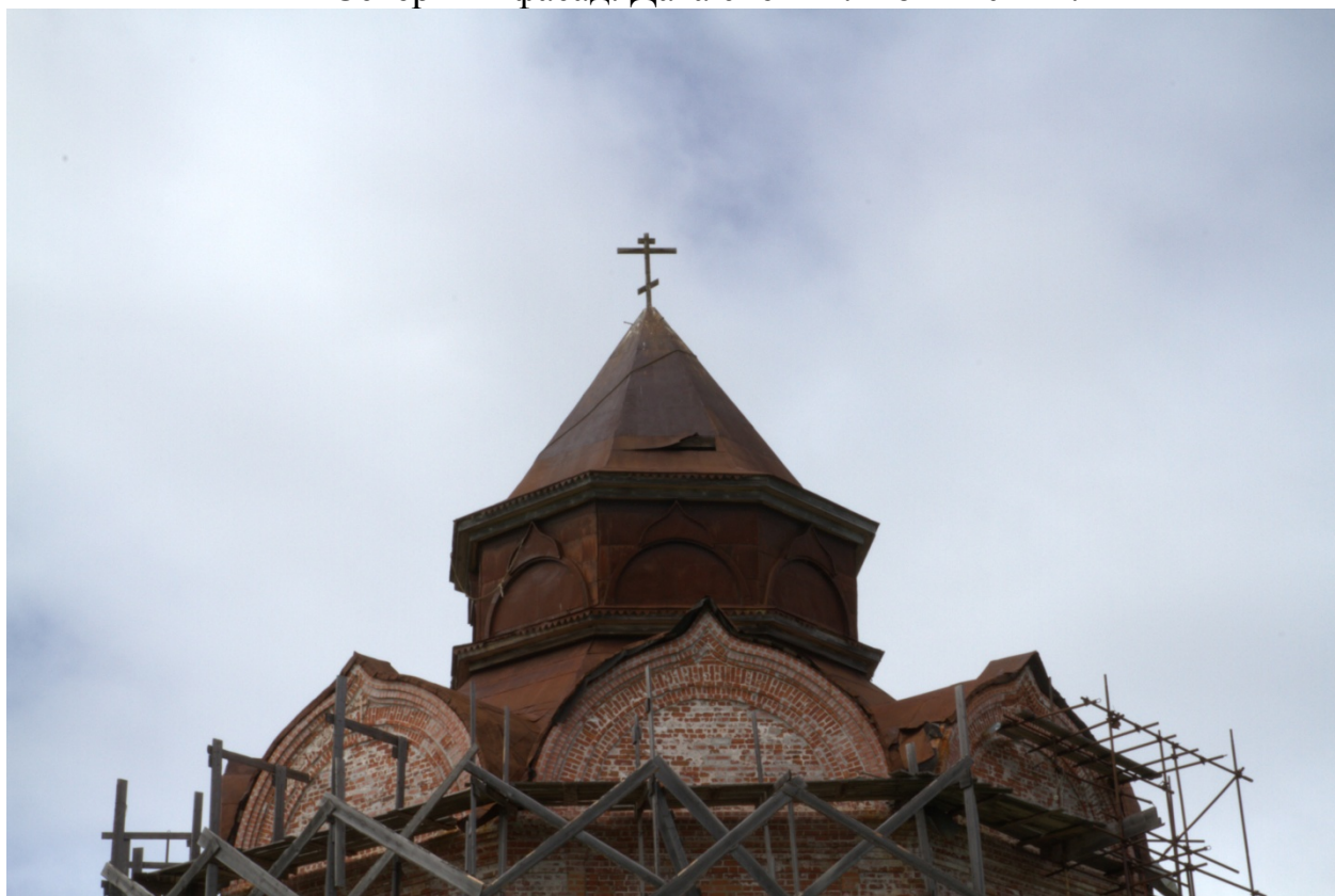
8. Повреждённый участок покрытия купола храма Святой Троицы. Вид с востока. Дата съемки: июнь 2014 г.
